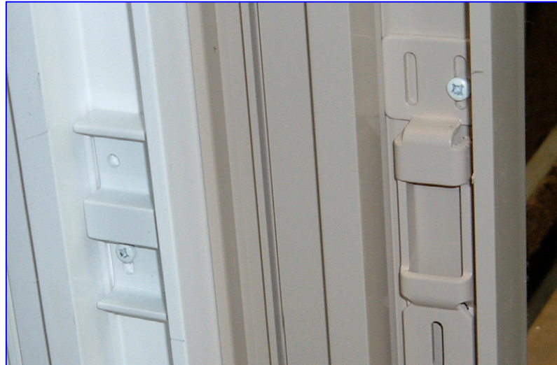
Patio Door 'Strike Plates'
